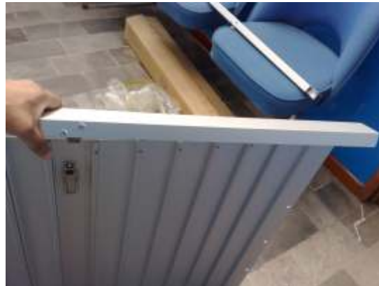
4. Coloque el primer tubo lateral insertando la rampa en la rendija colocando el gancho enfrente del sujetador
